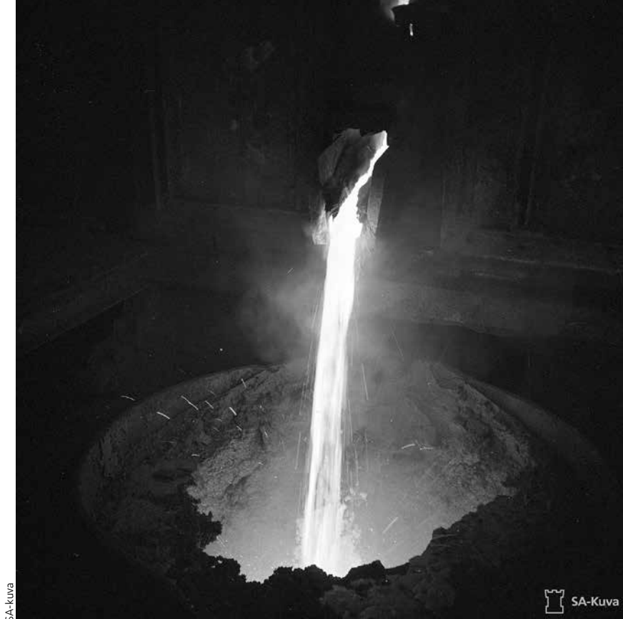
Kupari oli strateginen metalli. Sulaa kuparia juoksetetaan sähköuunista pataan Outokummun tehtaassa keväällä 1942.
